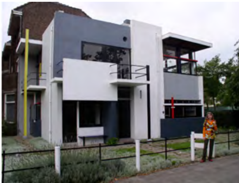
Рисунок 2б. Будинок Трус Шредер. 1924. Автор фото: Вергунов С. В. (поруч з будинком Вергунова Н. С.) Figure 2b. The Truus Schroder-Schrader House. 1924 Photograph by S. Vergunov (Nataliia Vergunova is standing next to the House)
